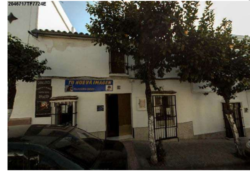
o Vivienda en calle Sargento Mena 4 (ficha catastral 19463/14)
