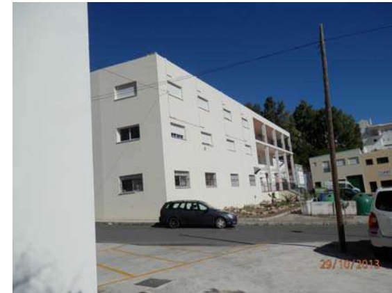
PABELLÓN USOS MÚLTIPLES EN POLIGONO INDUSTRIAL LA VENTILLA
