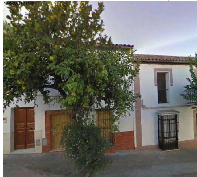
o Vivienda en calle Teniente Trujillo 6 (ficha catastral 20467/6)
