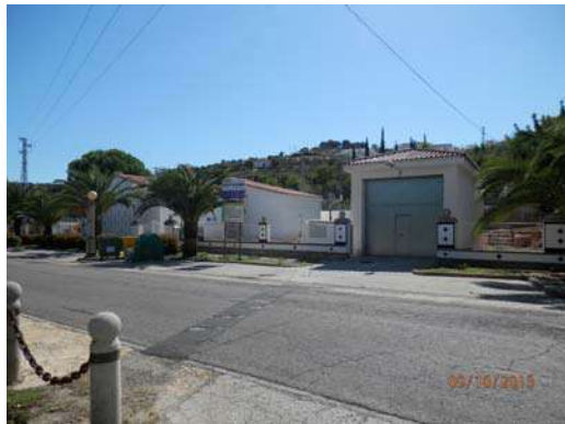
BOMBEO AGUAS RESIDUALES TRAVESIA A-373R
