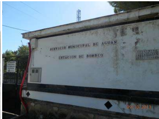
BOMBEO AGUAS LIMPIAS TRAVESIA A-373R
